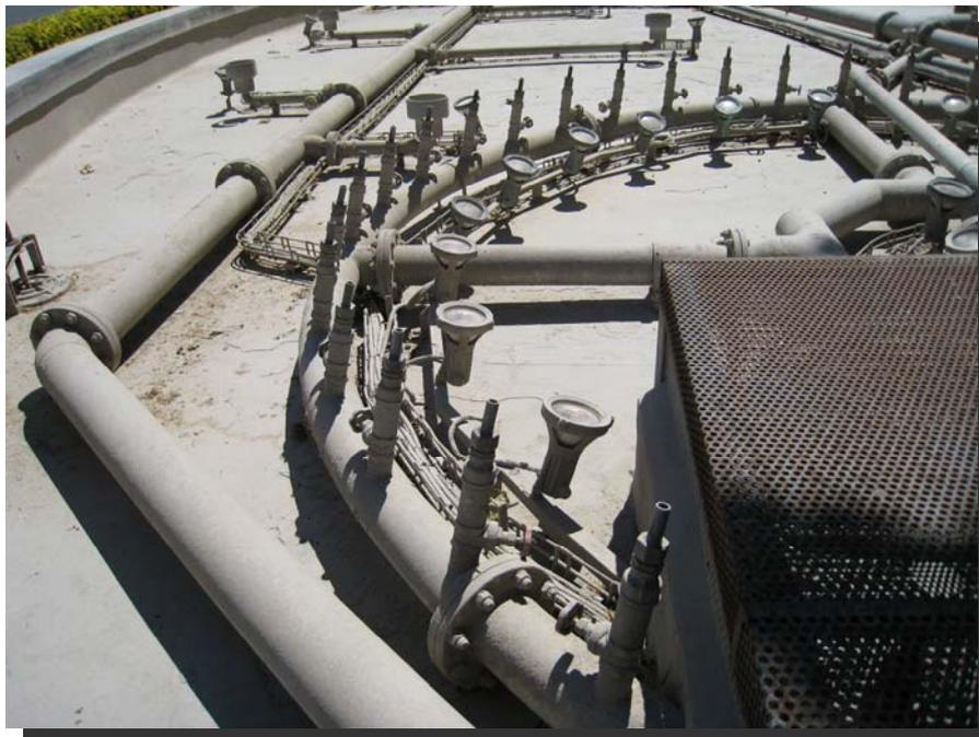
*Fotografía 2: Focos de 120 W junto a toberas de agua en el vaso de la fuente.*
