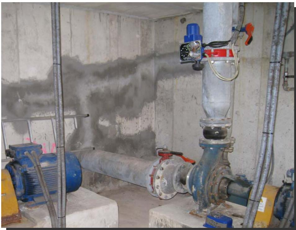
*Fotografía 4: Electroválvula en tubería de salida de bomba.*
