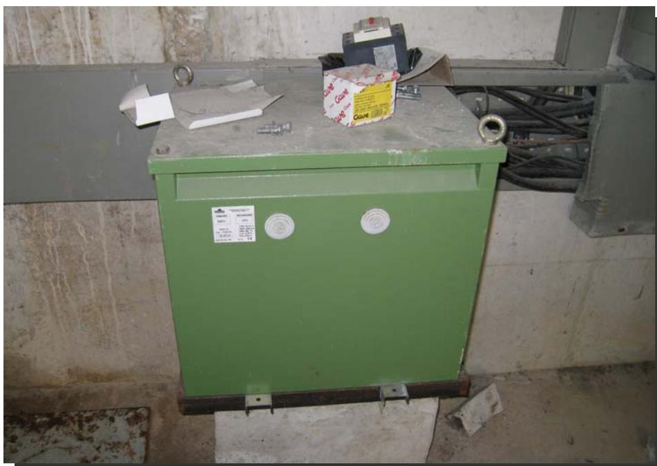
*Fotografía 2: Transformador de 380 / 24 V.*
