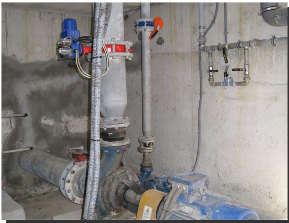
*Fotografía 3: Electroválvula en tubería de salida de bomba.*
